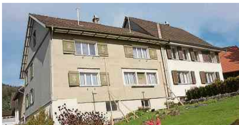
Für den Abbruch dieses Hauses in Zuckenriet erhalten die Bauherren Geld.
